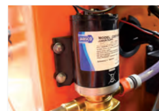
Selbstansaugende Wasserpumpe
